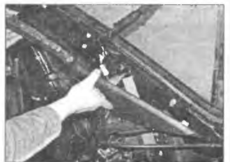
Рис. 27.20. Снятие панели отделки задней стойки
