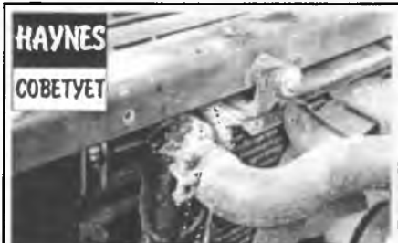
Последствия утечки в системе охлаждения обычно представляют собой отложение белого цвета или цвета ржавчины в проблемной зоне
