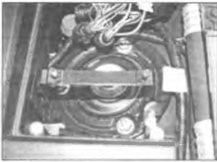
Рис. 2.7. Отпустите гайки верхнего крепления стойки подвески
